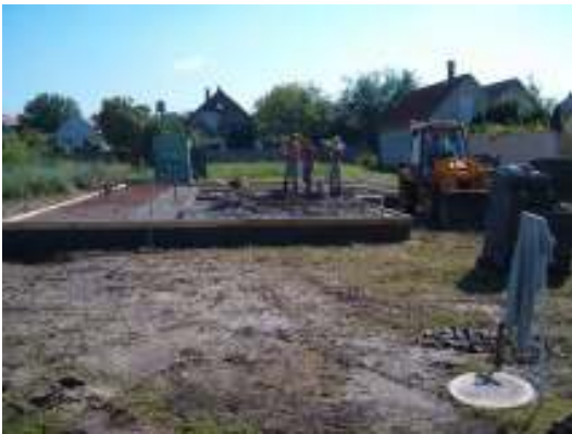
betónovanie podkladovej konštrukcie
