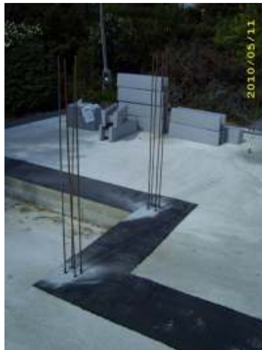
hydroizolácia pod stenami
