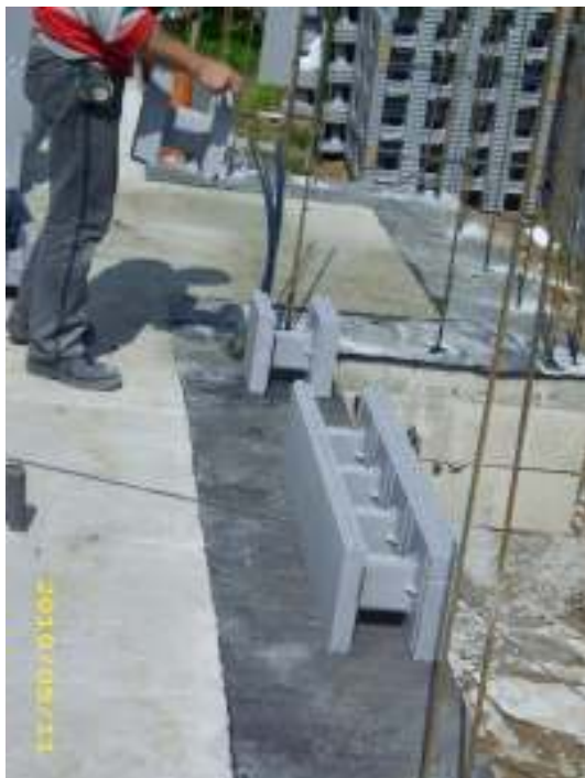
hydroizolácia pod stenami
