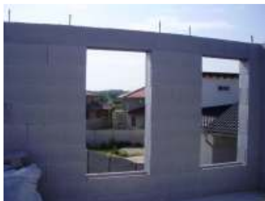
ukladanie prekladových tvárnic
