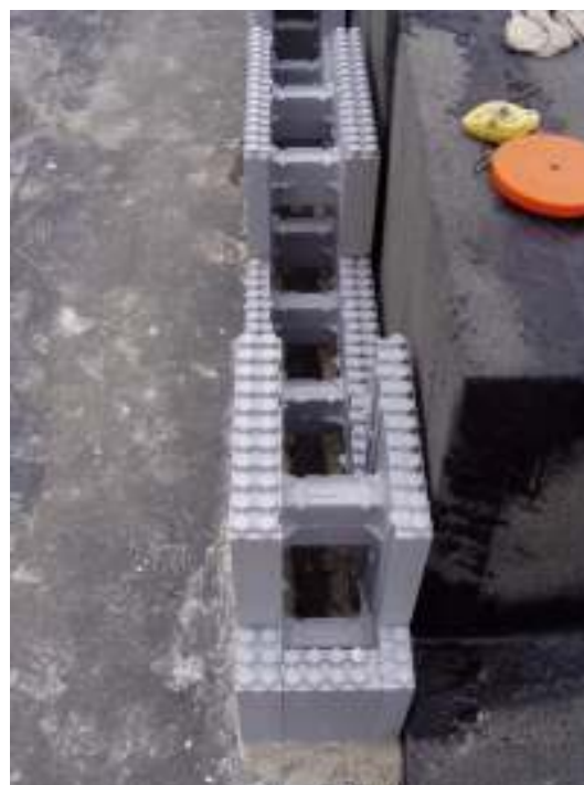
hydroizolácia bočných stien
