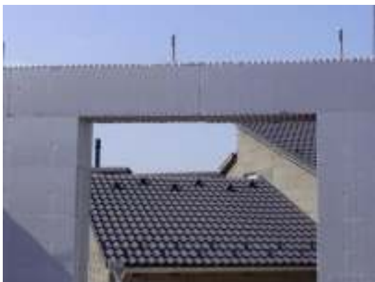
ukladanie prekladových tvárnic
